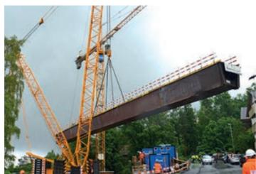
Die Brücke aus Cortenstahl wird an einem Stück über dem Sagenbach in Walchwil montiert.
