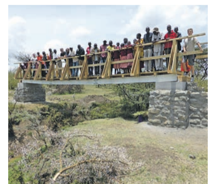
Die neue Fussgängerbrücke ist für die Einwohner eines Dorfs in Kenia lebensnotwendig.
