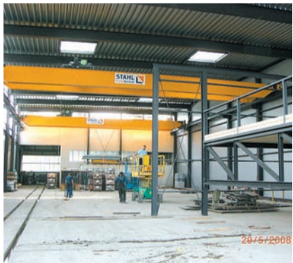
Mageba erweitert und modernisiert ihre Produktionsstätte in Fussach bei Bregenz markant
