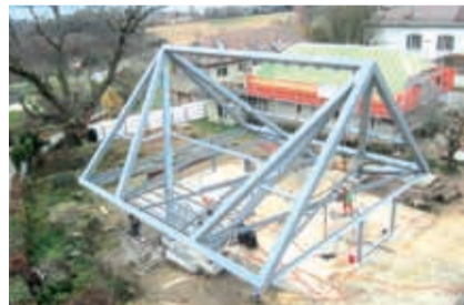
Ein Stahlbau mitten in den Weinbergen von Chigny oberhalb des Genfersees: Stahlskelett von Baltensperger AG.
