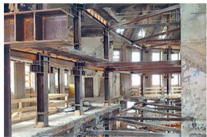
Komplette Aushöhlung und Stützung eines geschützten Gebäudes mit einer Stahlkonstruktion in Zürich.
