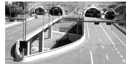
Die Reppischtalbrücke: Eleganter Verbindungsbau zwischen Eggrain- und Hafnerbergtunnel
