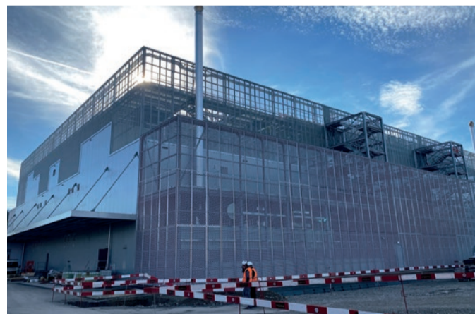
Stahlkonstruktion von Baltensperger: Data Center. (Foto: Baltensperger AG)
