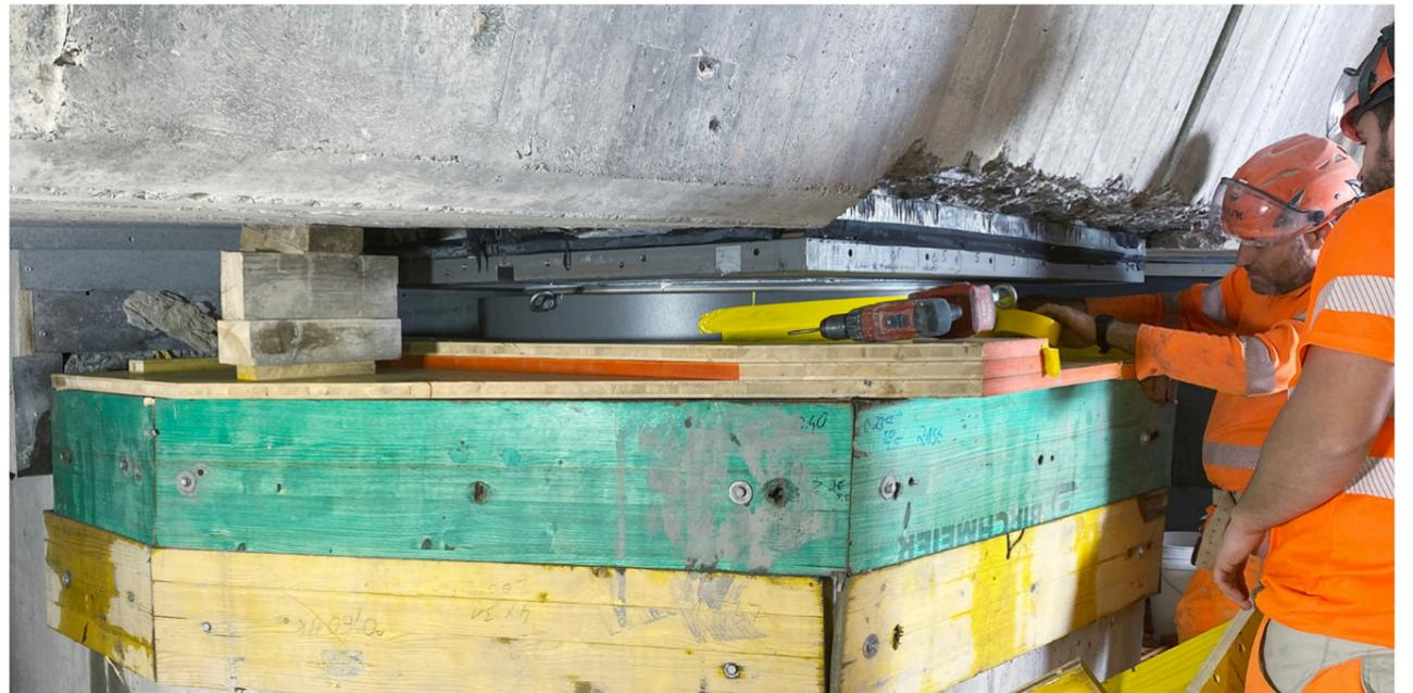
Sie tragen die Last einer sechsspurigen Autobahn: Arbeiter wechseln beim Hammermühlviadukt in der Nähe von Zürich die Brückenlager aus. (Foto: Mageba SA)
