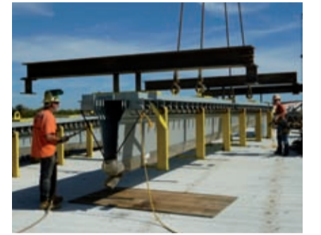
Arbeiter verlegen eine Gleitfingerfuge der Mageba SA
