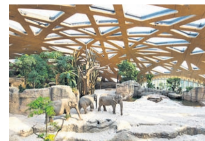
Das Monitoringkonzept des markanten Dachs des Kaeng Krachan Elefantenparks im Zoo Zürich stammt von Mageba SA. (Foto: Zoo Zürich, Jean-Luc Grossmann)
