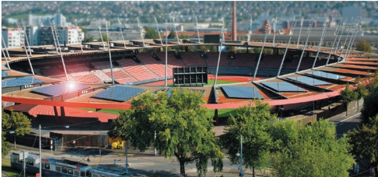
Stahl von Baltensperger AG steckt auch im neuen Stadion Letzigrund
