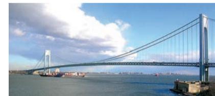
Mit einer Länge von 2093 m die längste Hängebrücke auf dem amerikanischen Kontinent: die Verrazano Narrows Bridge in New York.
