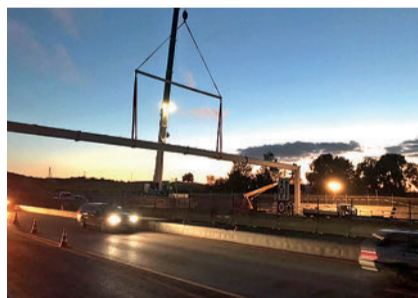
Montage eines Signalportals über der Nordumfahrung der A1 in den Abendstunden.
